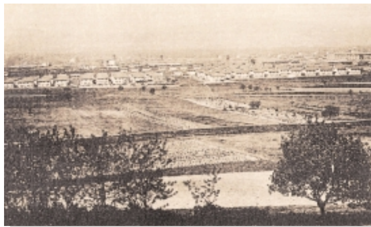
Salaise après la construction des cités
